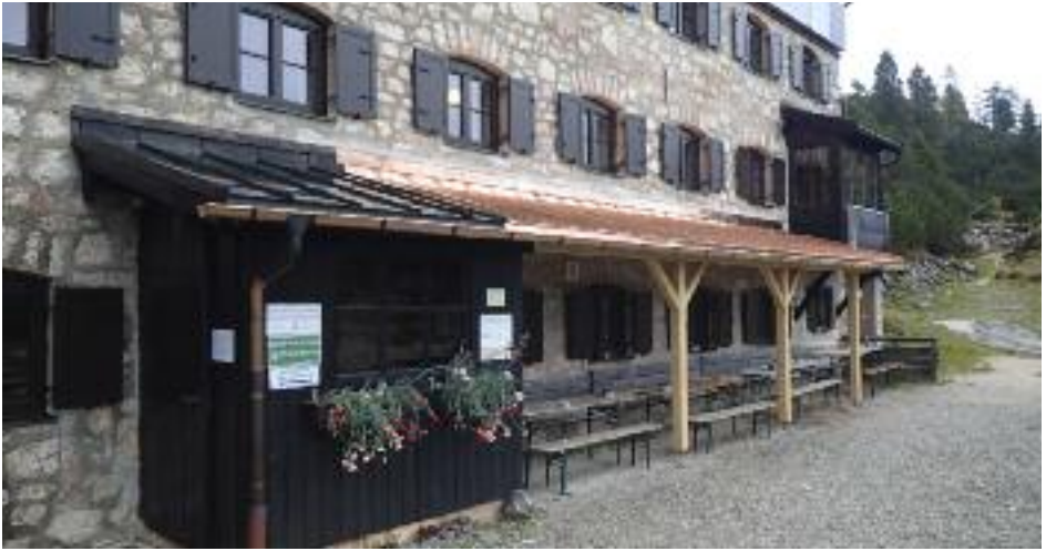
Besucher der Neuen Traunsteiner Hütte können dank des neu angebauten Vordachs auch bei schlechtem Wetter im Freien sitzen. (Fotos: Hans Gfaller)
